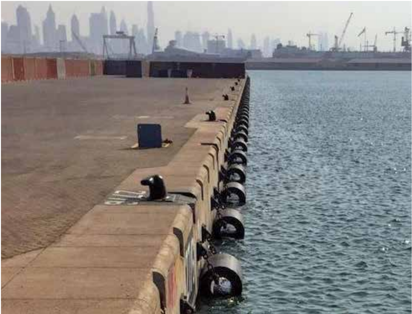
Rashid Port Berth 25 | Dubai | U.A.E.
