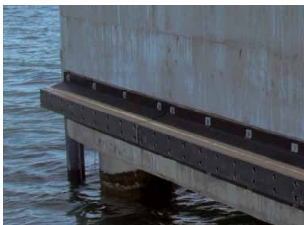
Ethanol Jetty | Stenungsund | Sweden
