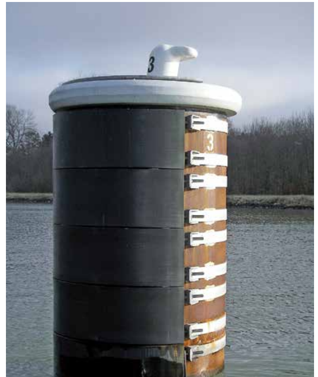
Standby piles | Kiel | Germany
