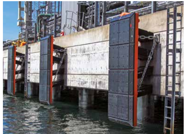
Ethanol Jetty | Stenungsund | Sweden
