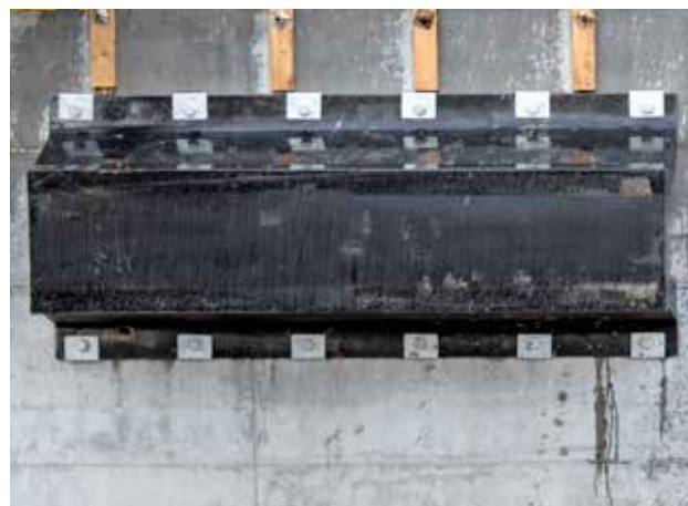
Boudewijnkanaal | Zeebrugge | Belgium
