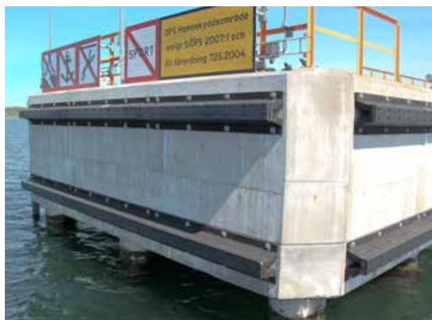
Ethanol Jetty | Stenungsund | Sweden
