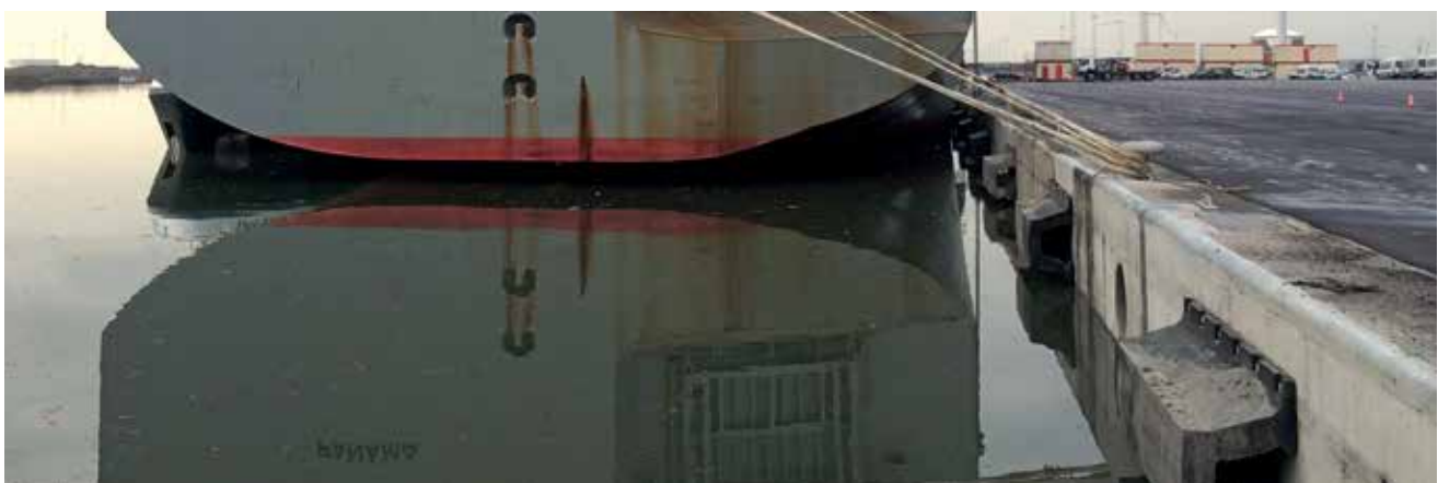
Toyotakaai | Zeebrugge | Belgium
