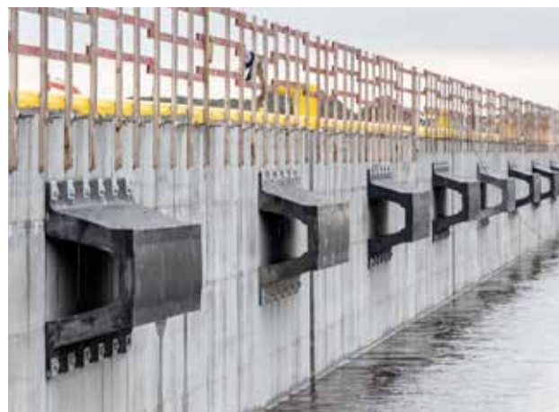
Boudewijnkanaal | Zeebrugge | Belgium
