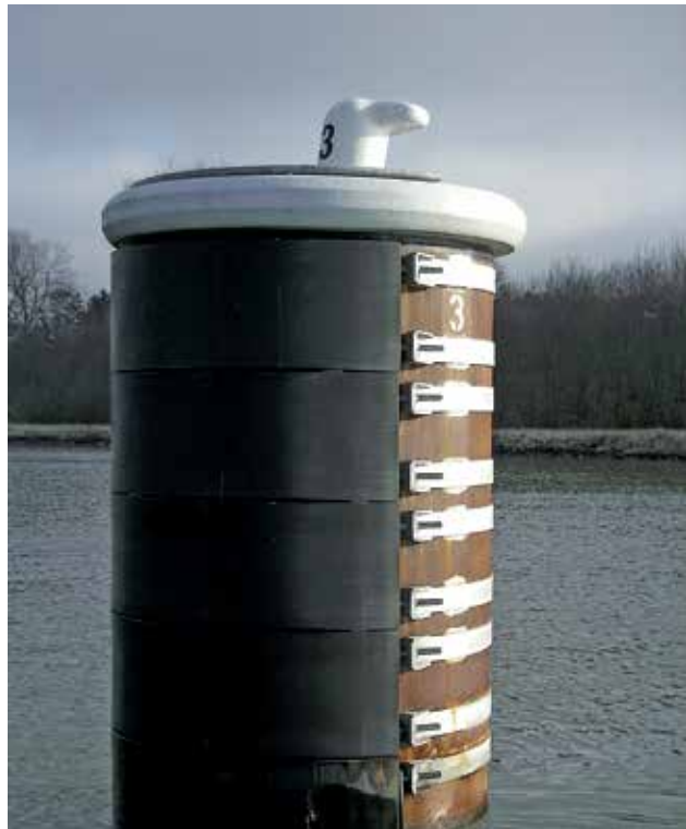
Standby pile | Kiel | Germany
